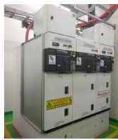
Gambar 1. Kubikel MV 20kV
